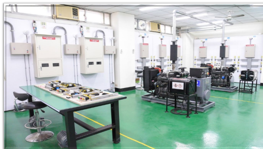
機電設備實習工廠(E棟)
