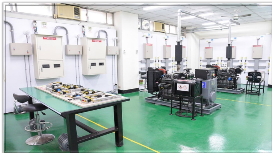
機電設備實習工廠(E棟)
