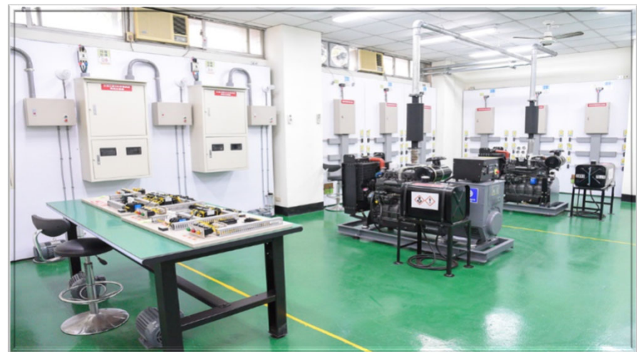
機電設備實習工廠(E棟)
